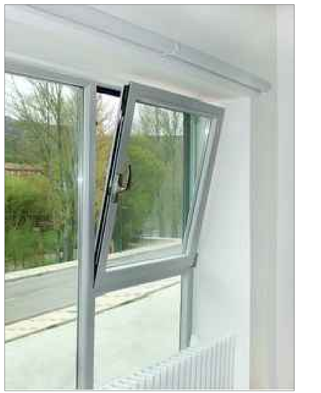
VENTANAS SISTEMA PROYECTADAS P92 CON MARCO ALUMINIO COLOR GRIS / GROSOR VIDRIO 3/16" COLOR VIDRIO NATURAL TRANSPARENTE CON SISTEMA DE PUÑOS EN CIERRE.
